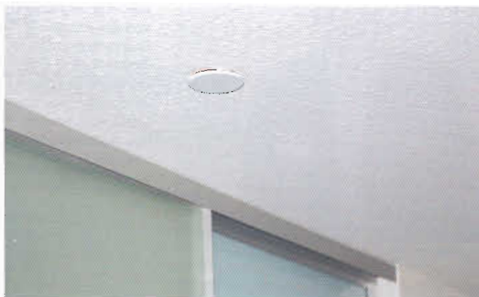
Der Industrie-Charme der Sprinklerköpfe findet sich im „inHaus“ nur noch bei der Absicherung des Dachbodens, über den die Zuleitungen geführt wurden. In den Räumen schützen Designventile.
