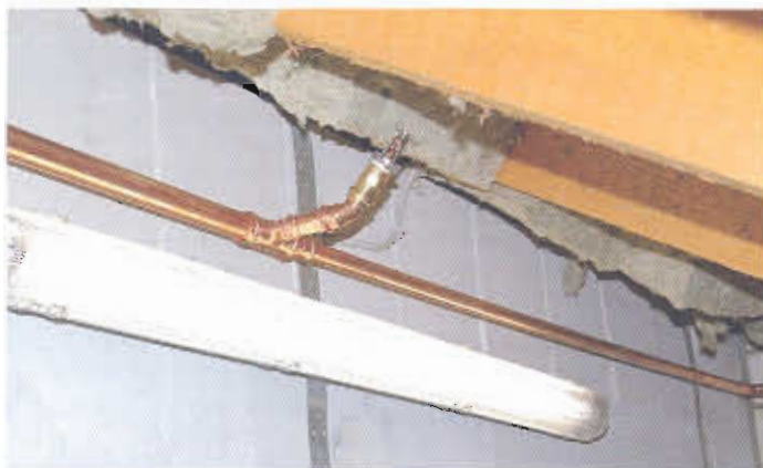
Der Industrie-Charme der Sprinklerköpfe findet sich im „inHaus“ nur noch bei der Absicherung des Dachbodens, über den die Zuleitungen geführt wurden. In den Räumen schützen Designventile.
