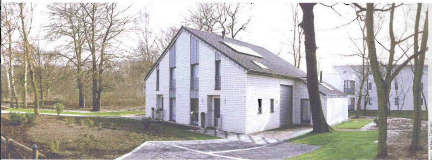
Testobjekt für die Zukunft Im „inHaus1“ in Duisburg werden neue Systeme für das Haus der Zukunft getestet
