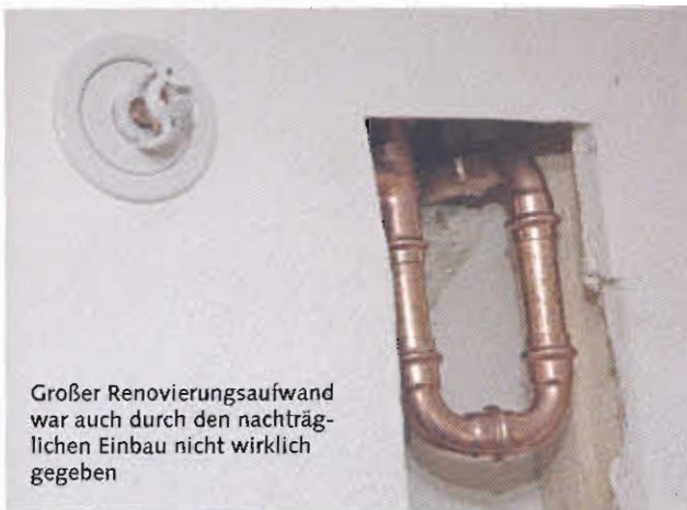
Verschiedene Sprinklertypen kamen zum Einsatz, da man sich an vorhandenen Möglichkeiten orientieren musste und auch dekorative Unterschiede aufzeigen wollte
