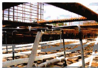
Verlegung der Rohre für die Betonkernaktivierung
